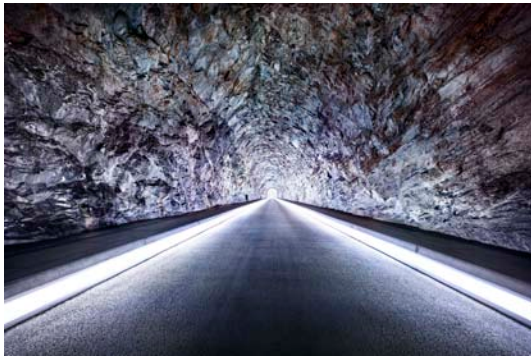
Ferrera | Centrale hydroélectrique, entrée de la centrale
